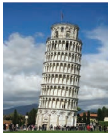
شکل ۱-۶- نشست نامتقارن پی در برج پیزا
