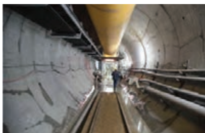
ب) پوشش‌های بتنی در مترو
