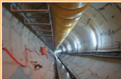
تونل انتقال آب (تونل کانی سیب - پیرانشهر)
