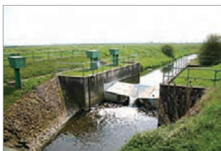
شکل ۲-۳- ایستگاه اندازه گیری آب دهی رود
