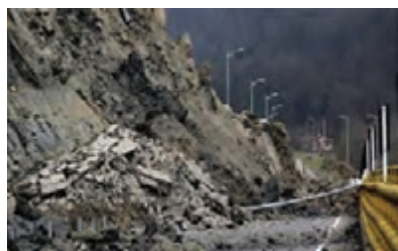
شکل ۱۴-۶ لغزش مصالح
