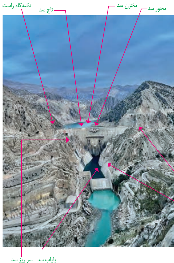
شکل ۱۷-۶-۱ نمای از بخش‌های مختلف یک سد
