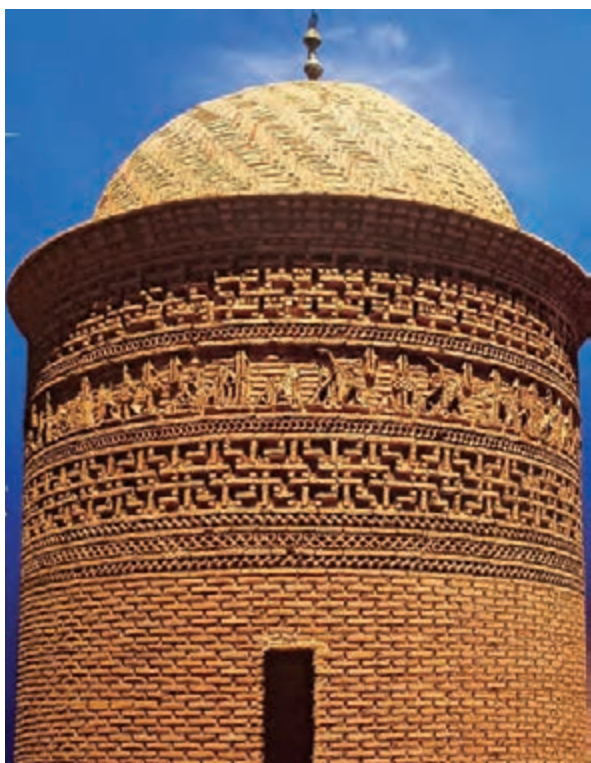
برج آجری پیر علمدار، دامغان - در دوران سلجوقی آجر به مرور سبک تر و ظریف تر ساخته شد و برای تزیین و نماسازی بنا به کار گرفته شد.
