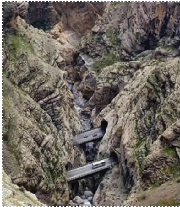
پل زال و تونل گندم کار در مسیر آزاد راه خرم آباد — پل زال
