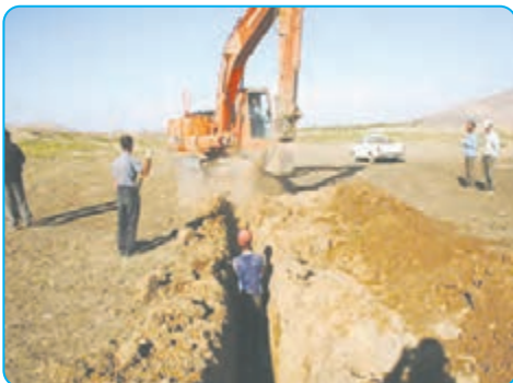
کندن زمین با بیل مکانیکی
