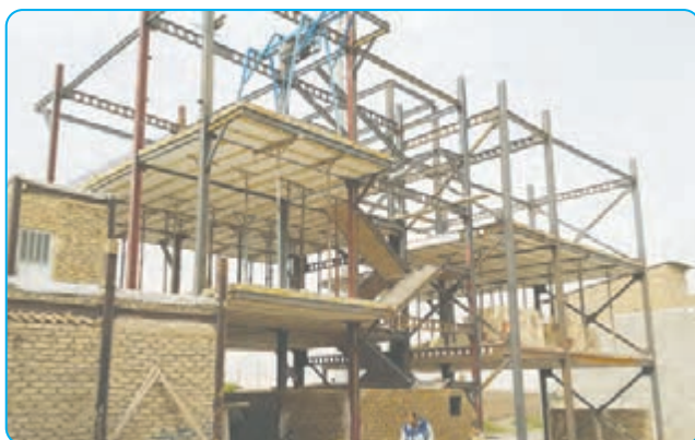
خانه‌ی در حال ساخت
