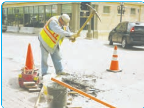
استفاده از کلنگ در کندن زمین
