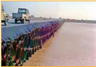
پل بعثت بر روی رودخانه اروندرود
