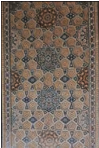
▲ کاشی‌کاری دیوار امامزاده محروق، اثر استاد زمرشیدی
