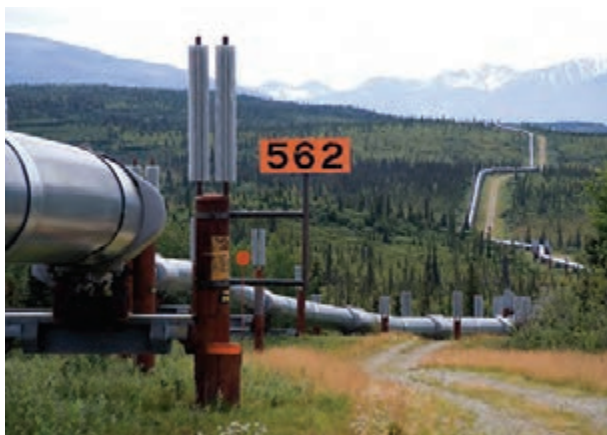
بزرگ‌ترین سامانه خط لوله صعب العبور جهان به طول ۱۳۰۰ کیلومتر خط لوله ترانس - آلاسکا است که در زمین های یخ بسته (پرما فروست) احداث شده و نفت را از خلیج آلاسکا به سواحل اقیانوس منجمد شمالی انتقال می دهد.
