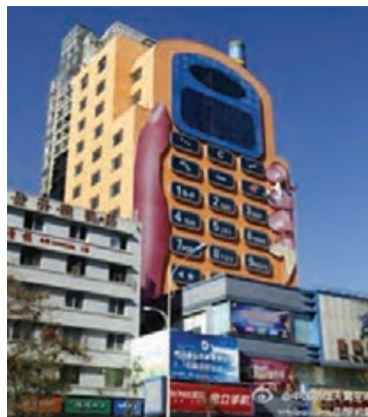
شکل ۱۱۰-۳- تصویر چاپ بر روی ساختمان
