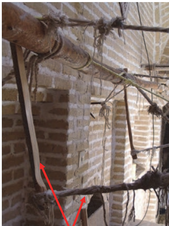
شکل ۳۶- کمونه و نخ اتصال آن
