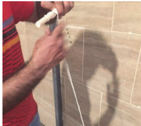
شکل ۶۷- پیچیدن نخ ها روی چوب ماسوره
