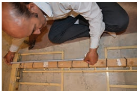
شکل ۱۸-۵ - نشانه‌گذاری بر روی چوب پایین‌کشی
