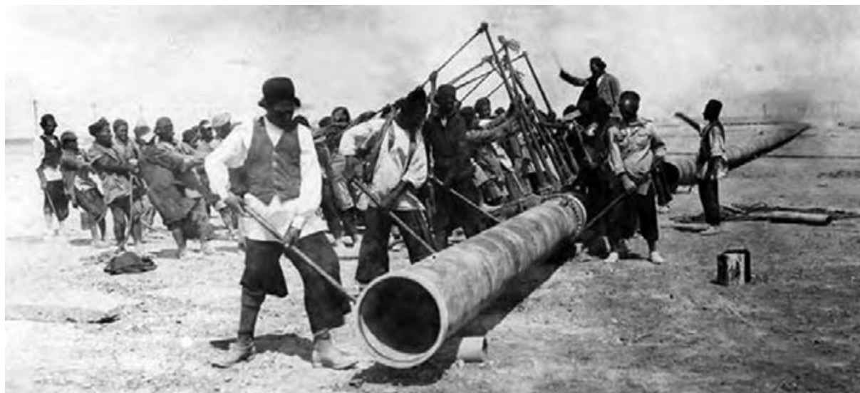
کارگران شرکت نفت هنگام احداث خط لوله نفت در خوزستان
