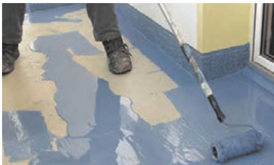
شکل ۴-۱۰- یکی از روش‌های اجرای اپوکسی
