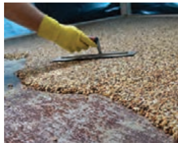
شکل ۳-۴۳ - نمایش نحوه پخش و اجرای اپوکسی گرانیتی
