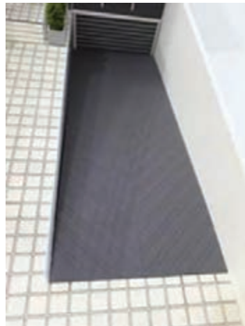
شکل ۱۰۹-۵- اجرای شیپ‌های رامپ با کاتر و فشار دست
