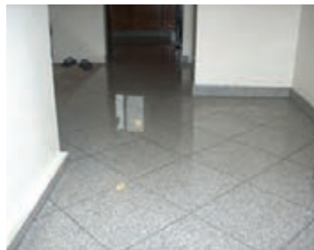
شکل ۳-۴۵ - کف سازی نهایی با پوشش اپوکسی گرانیتی شطرنجی
