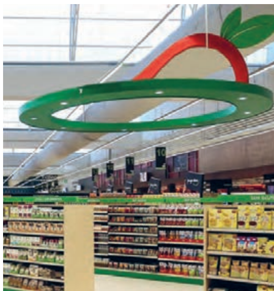
شکل ۵-۳- سقف‌های آویز مشبک با چراغ‌های توکار هالوژن یا ال ای دی
