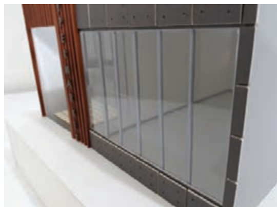
شکل ۵-۸۹- نصب شیشه‌های ساخته شده بر روی نما
