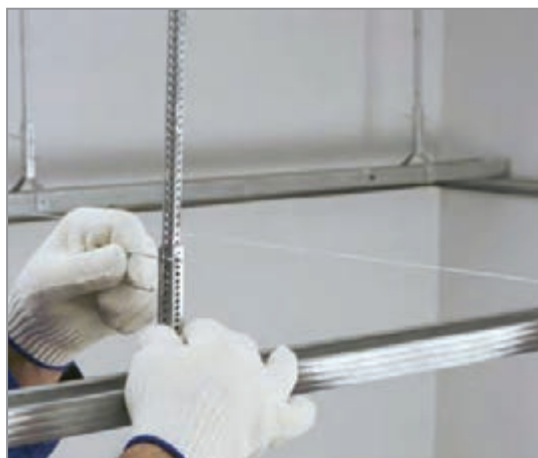
شکل ۴-۱۹- جزئیات و اتصالات شاسی سقف‌های کاذب
