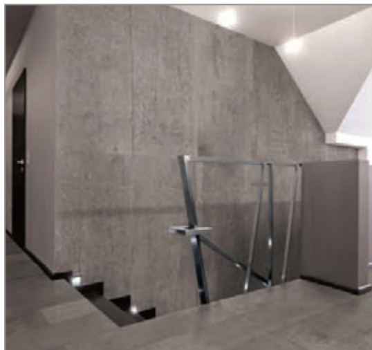
شکل ۴-۱۵ یک جداره داخلی از بتن نمایان قالبی
