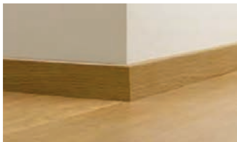
شکل ۷۶ - اتصال قرنیز در کنج به صورت فارسی
