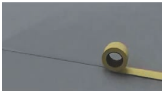
شکل ۲۰ تا ۲۳ - مراحل اجرای فوم روی کف (فاصله بین فومها با چسب کاغذی پوشیده شود)
