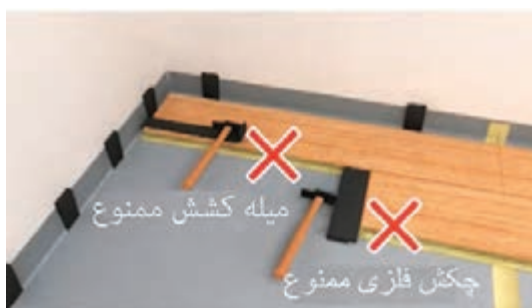
شکل ۴۵ تا ۴۷ - اشتباهات رایج در اجرای کف پوش لمینت
