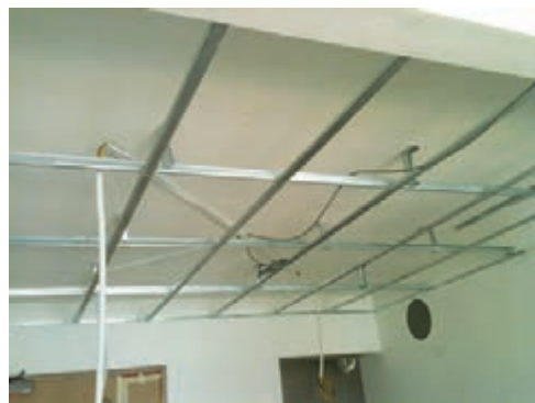
شکل ۱۶- بررسی تأسیسات و محل عبور سیم برق
