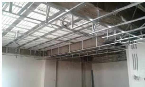
شکل ۱۶- بررسی تأسیسات و محل عبور سیم برق
