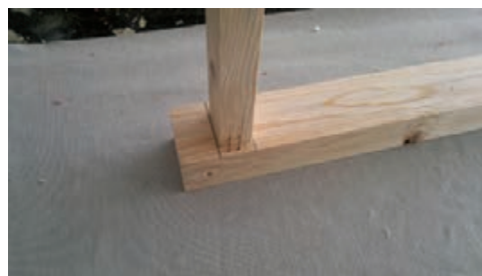
شکل ۴۹- زدن دو منگنه روی قید اول
