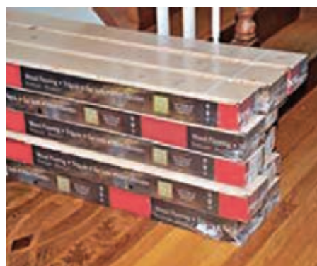
شکل ۲۶ و ۲۷- نحوه قرار دادن درست جعبه‌های لمینت
