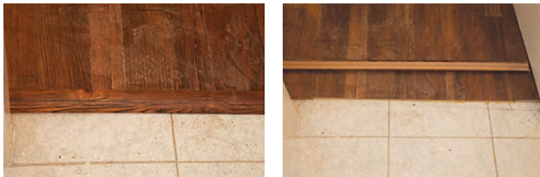
شکل ۸۲ و ۸۳ - پشت و روی پروفیل آستانه
