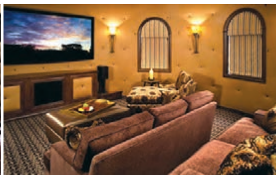
شکل ۷- استفاده از صفحات صداگیر در دیوارپوش در سینمای خانگی
