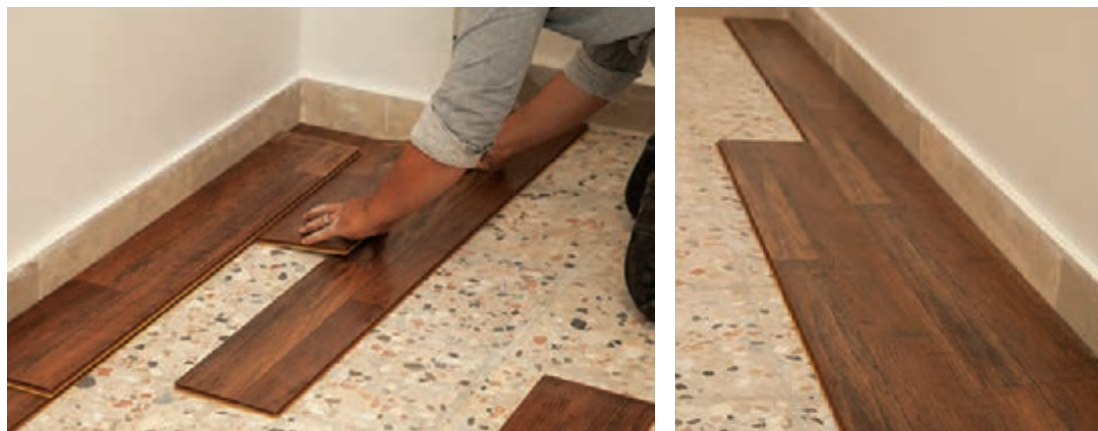
شکل ۳۵ و ۳۶- نصب ردیف اول و دوم کف پوش لمینت بر روی موزاییک
