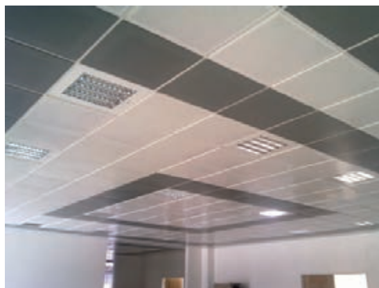
شکل ۱- اجرای سقف کاذب با مواد صداگیر
