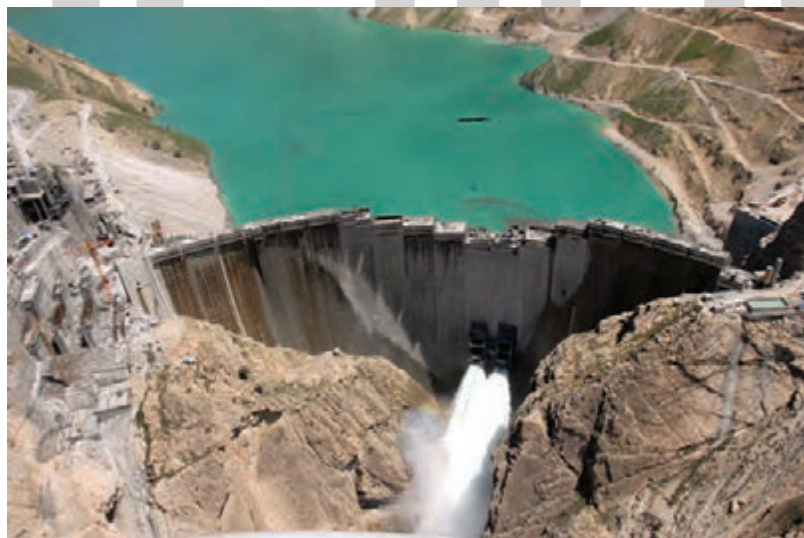
شکل ۵- سد کارون (۴) - خوزستان
