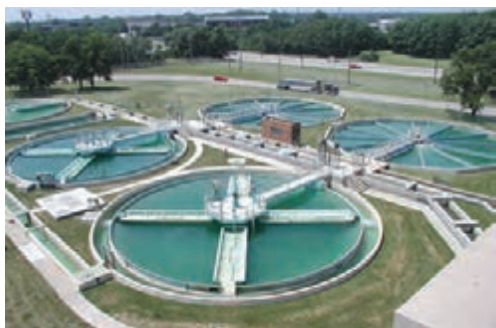
تصفیه آب در تصفیه خانه
