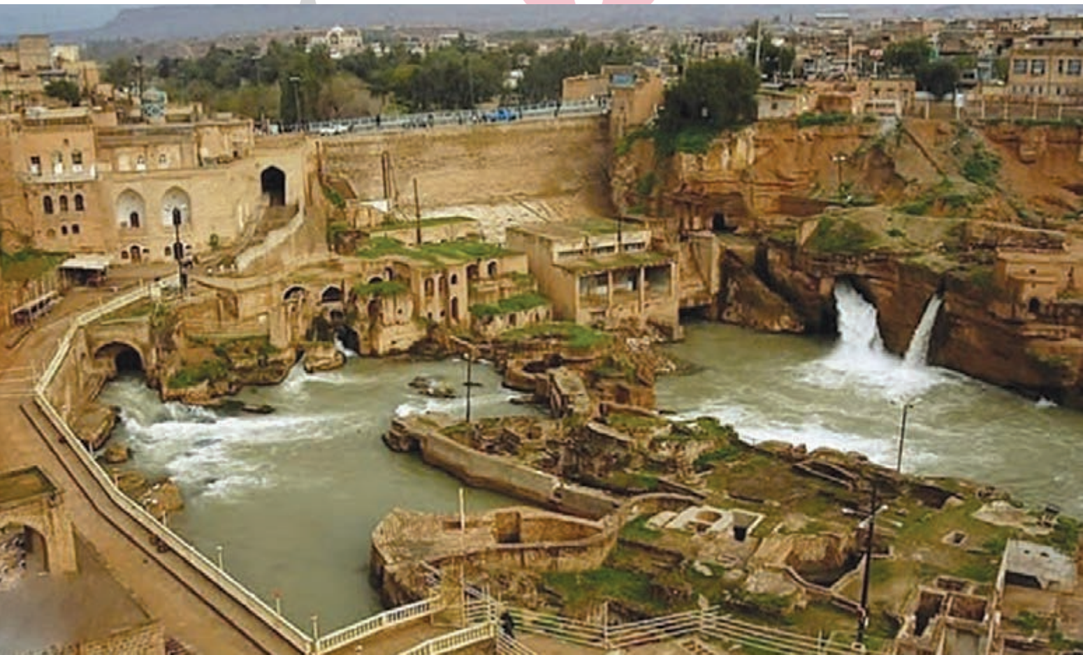
شکل ۵- سازه‌های آبی - تاریخی، شوشتر، خوزستان
