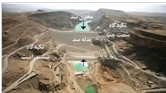
شکل ۴-۵- نمایی از بخش‌های مختلف یک سد
