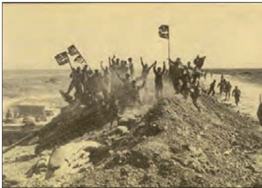
تصویر عملیات بیت المقدس
