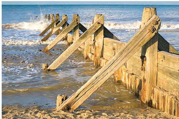
نصب حفاظ عمودی
