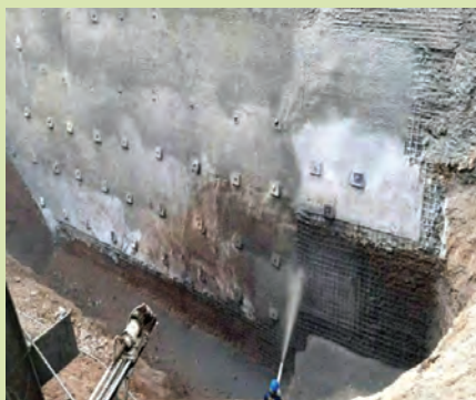
پایدارسازی شیب به روش میخ کوبی
