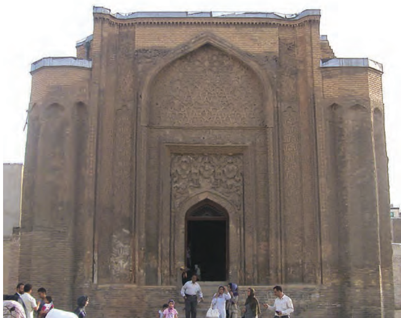
گنبد علویان از بناهای دوره سلجوقی - همدان
