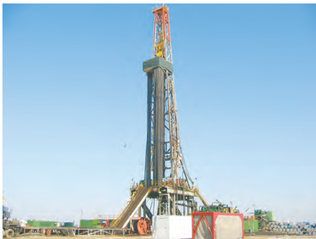
شکل ۱۰- دکل حفاری چاه‌های اکتشافی نفت و گاز
