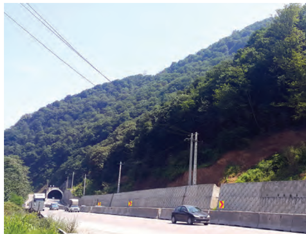
نصب حفاظ بتونی - جاده قائم‌شهر
