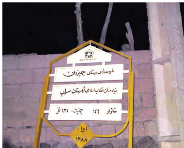
اجرای طرح هادی در یک روستا
