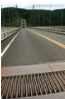
(ب) نمونه‌ای از بست‌های انبساطی
