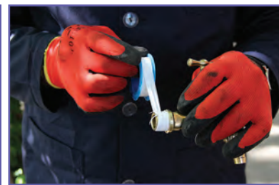
پ- پیچیدن نوار تفلون روی شیر نو
