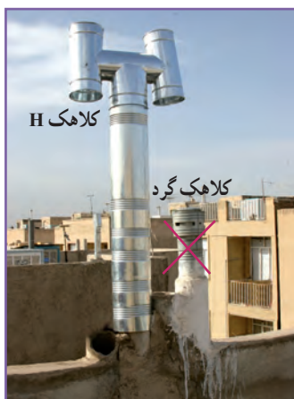
پ - برای خروجی دودکش هر دستگاه گاز سوز یک کلاهک H نصب شود.
