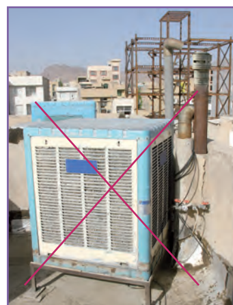
ب - فاصله بین دودکش تا کولر آبی و یا پ - برای خروجی دودکش هر دستگاه گاز سوز یک کلاهک H نصب شود. درجه های تأمین هوای ساختمان دست کم سه متر باشد.
