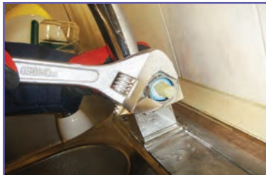
ث- باز کردن پیچ روی مغزی (گلند)
