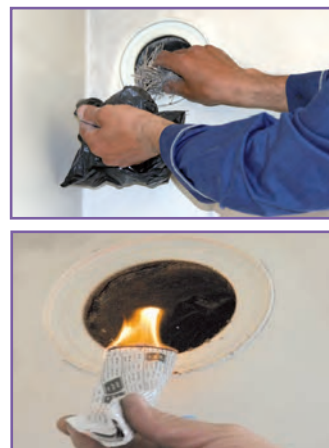
ج - قبل از راه اندازی دستگاه گازسوز از باز بودن مسیر دود در دودکش اطمینان حاصل کنید.
