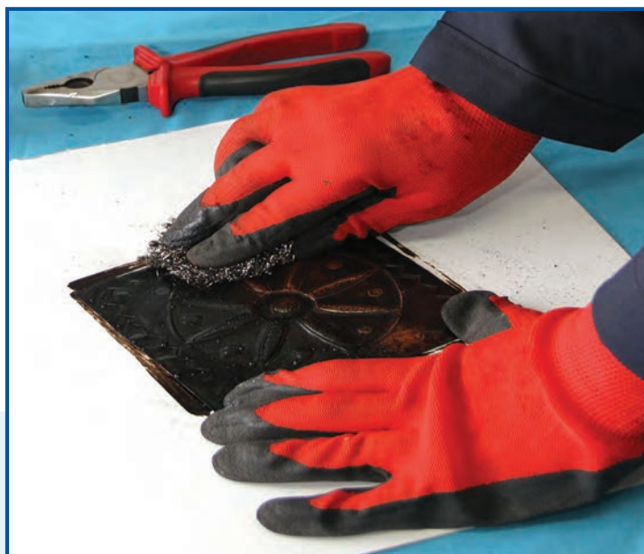
شکل ۱۱-۱- ساب زدن سطح پلاک مسی
