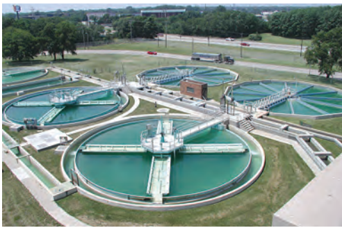
تصفیه آب در تصفیه خانه
